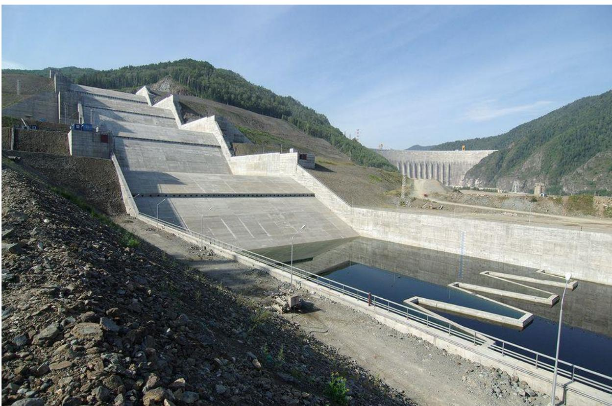
Рисунок 2 – Каскадный водосброс СШ ГЭС.
