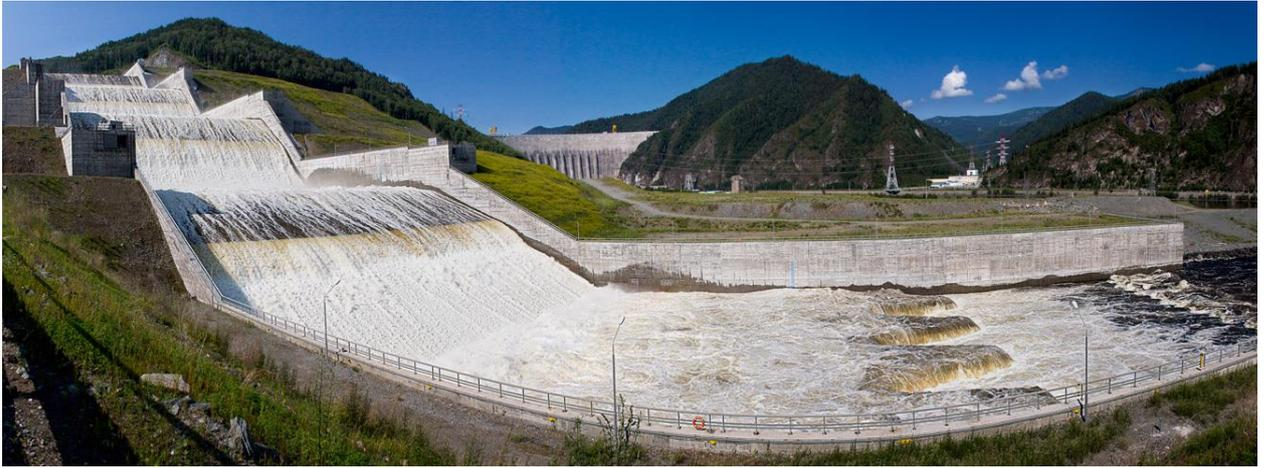
Рисунок 3 – Рабочий режим каскадного водосброса СШ ГЭС.
