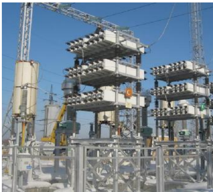
Рисунок 2 – Силовые конденсаторы
