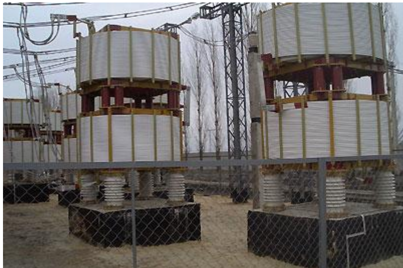
Рисунок 3 - Шунтирующий реактор
