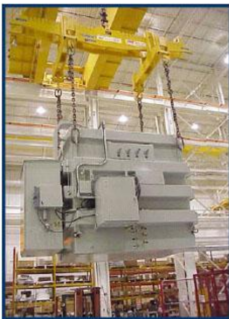
Рисунок 2 – Трёхфазный ВТСП трансформатор мощностью 5/10 МВА
