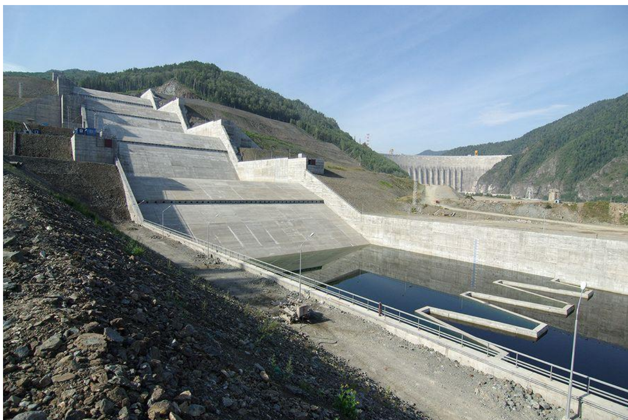
Рисунок 2 – Каскадный водосброс СШ ГЭС.
