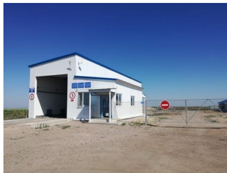
Рисунок 2 – Дезбарьер под навесом, для дезинфекции автотранспорта свинокомплекса
