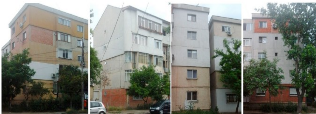
Рис. 1. Неэффективная система утепления наружных стен.
