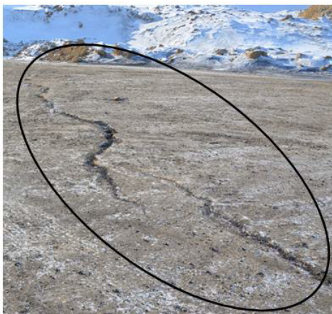
Рисунок 1 - Раскрытие трещин (Южная часть карьера)
