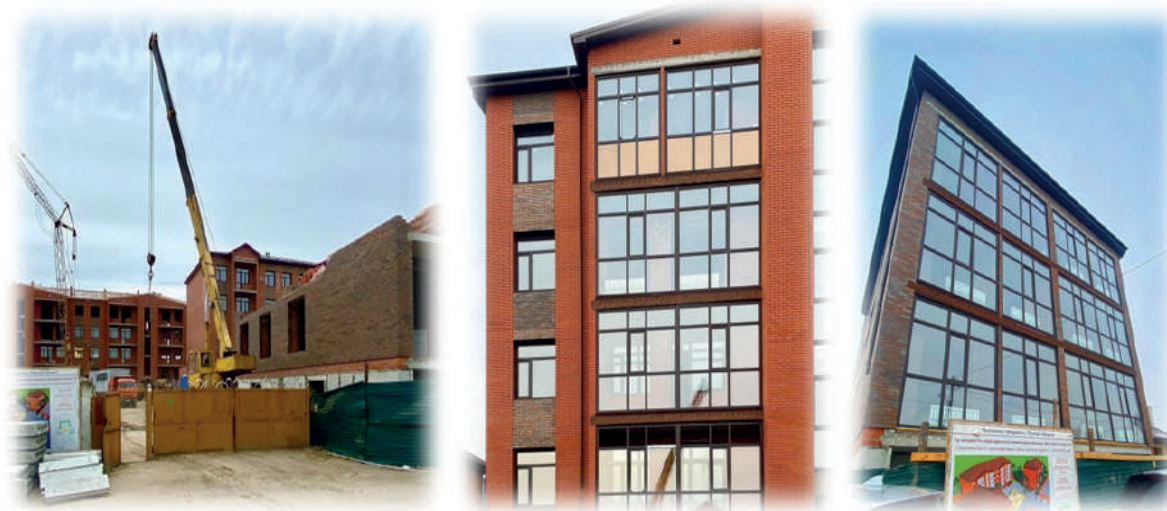
Рисунок 3 - Кровля жилого комплекса «AISULU»
