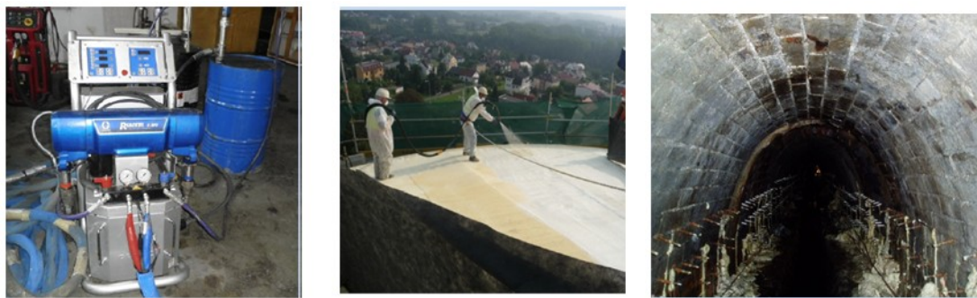
Рисунок 4 - Проходка туннеля с укреплением породы химическим способом
